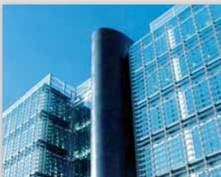
■ Fassade mit Metallunterkonstruktion
