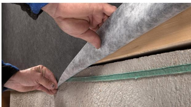
**7. In alternativa: giunzione su sottofondi grezzi o minerali (ad es. solai) con ORCON MULTIBOND**
