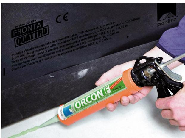
**6a. Fissaggio a supporti ruvidi o minerali (per es. lastre di pavimentazione)**
