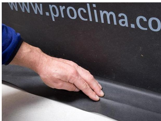
**6b. Raccordo a sottofondi ruvidi o minerali (p.es. lastre di pavimento)**
